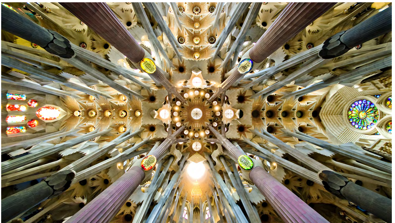
Gaudí's hyperbolic vault of the Sagrada Família nave (Barcelona).
